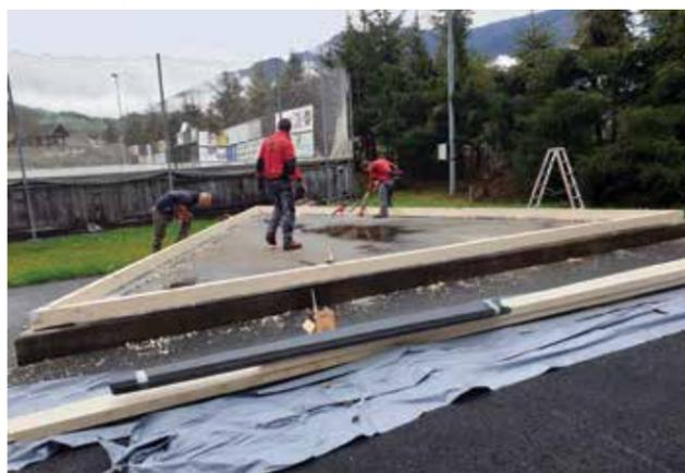
Bild: Auf das Fundament werden die Bodenschwellen montiert
