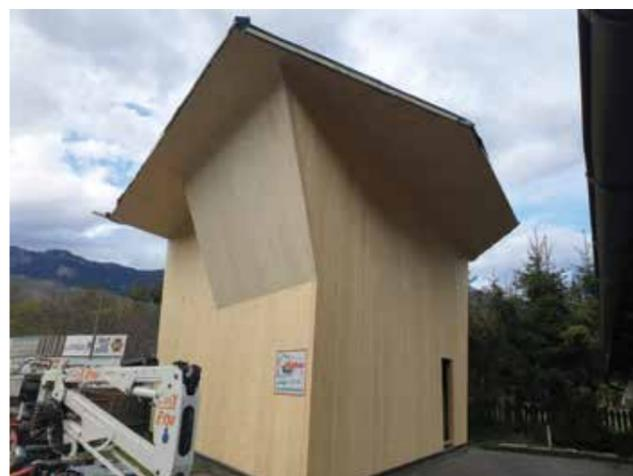
Bild: Der Kletterturm ist auf die doppelte Höhe erweiterbar
