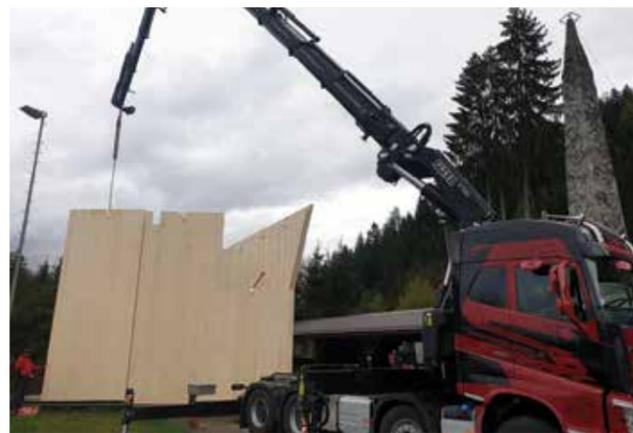
Bild: In Millimeterarbeit setzt der Kranfahrer die Wandelemente
