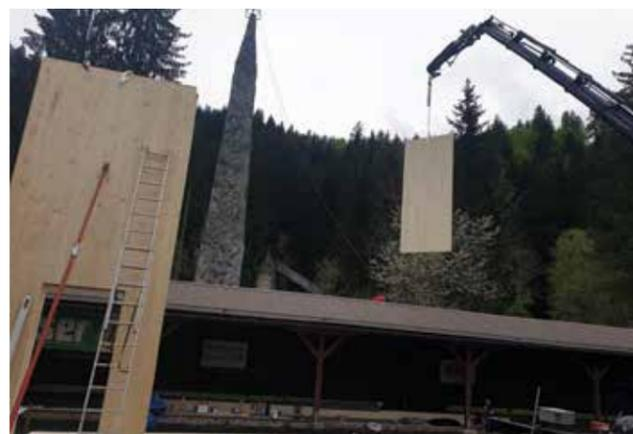
Bild: Die Einzelteile, fast zwei Tonnen schwer, werden angefügt
